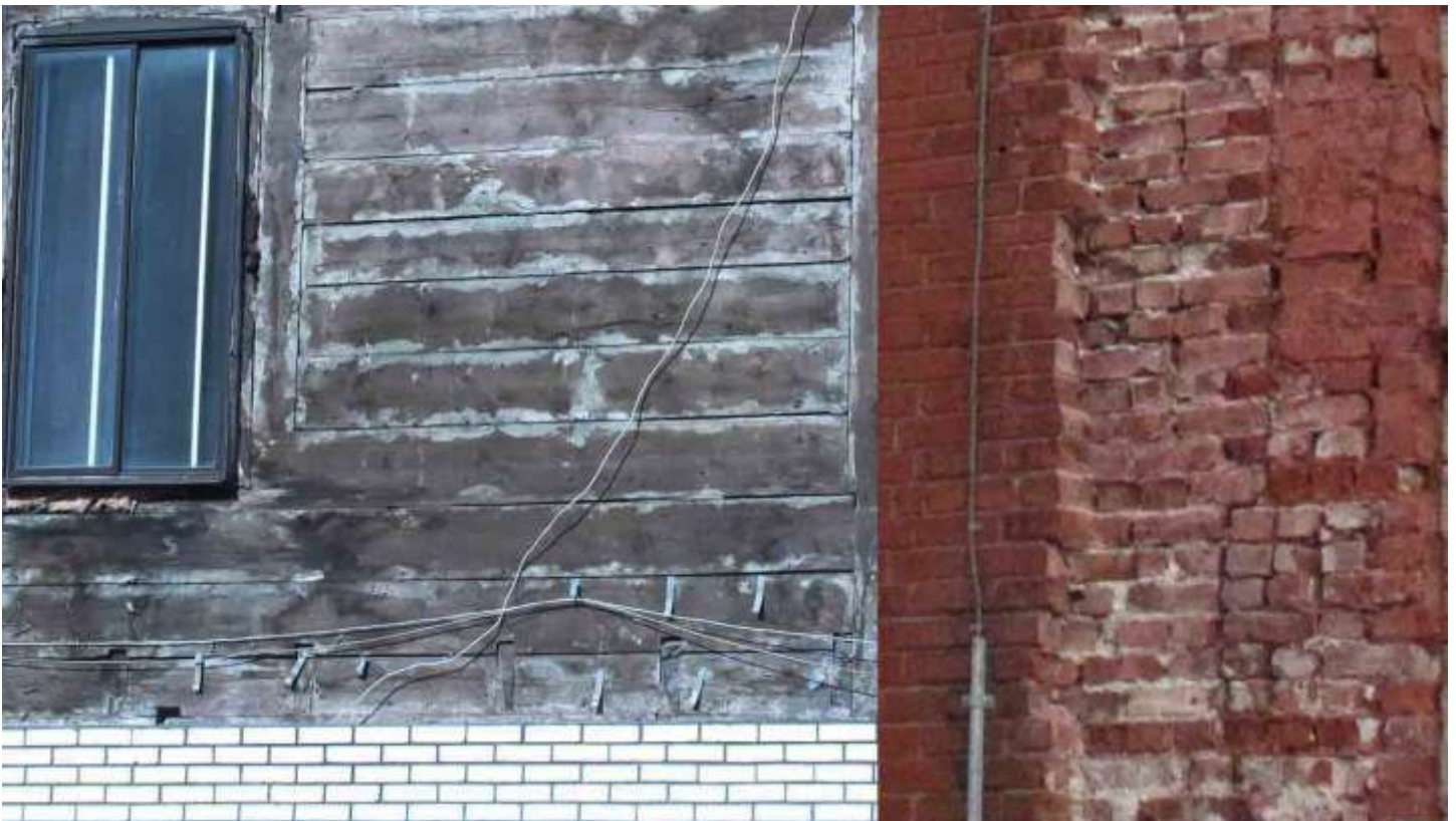
Figure 9. Deux types de construction bien différents: à gauche, presque toutes les briques de parement ont été arrachées pour laisser voir le carré de madriers; à droite, on a enlevé plusieurs briques du premier rang d'un assemblage de briques porteuses.
